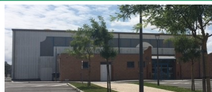
Salle Polyvalente Sol PVC Restauration sur place
