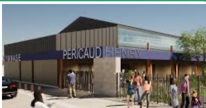
Gymnase Henry Péricaud Sol PVC, vestiaires, douches
