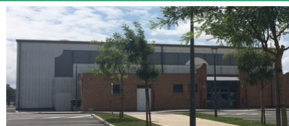
Salle Polyvalente Sol PVC Restauration sur place
